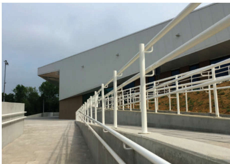
Depuis 2019, le CS Dyle bénéficie également de l'accès à une piste indoor. © Vincent Spletinckx
